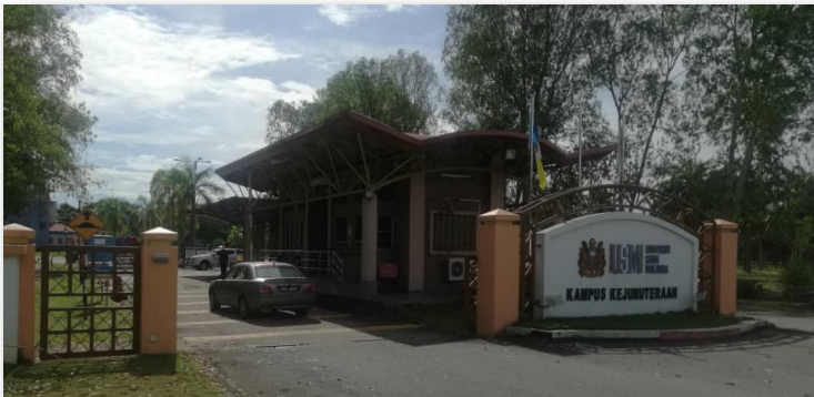
AKSES PINTU UTAMA
